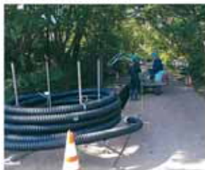
改修工事「総延長約650m」
